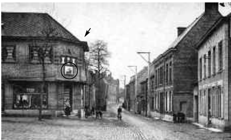
Georgine Heyman voor haar agentschap. Op de voorgevel een reclamepaneel van de Canadian Pacific Railway.
